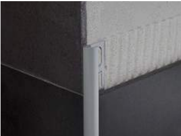
REF.*1240985 RA-ALUMÍNIO ANODIZADO PRATA RA-ALUMINIUM ANODISÉ ARGENT SILVER ANODISED RA ALUMINIUM
