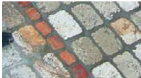
SUPERFÍCIE DEPOIS DA LIMPEZA FINAL DE OBRA COM DETERDEK
