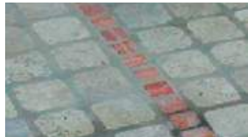
SOL EN MARBRE VIEILLI AVANT LE NETTOYAGE FINAL DES TRAVAUX
